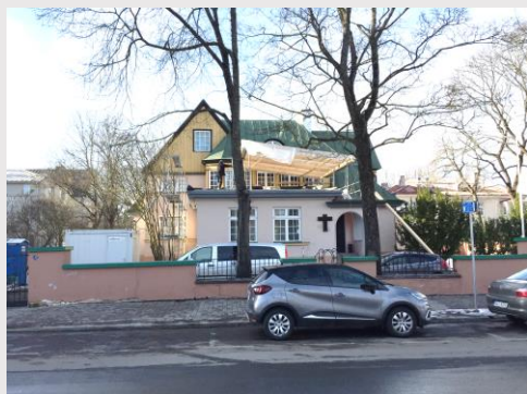
Ремонт крыши семинарии
