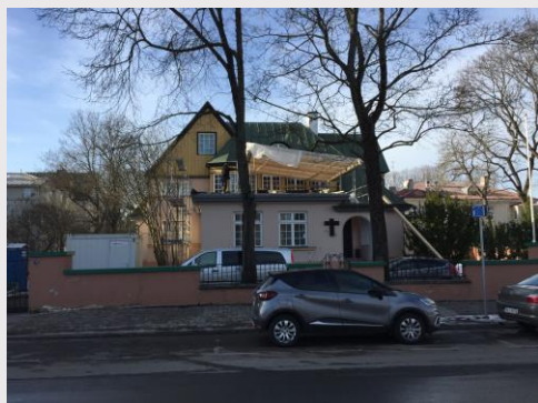
Lavori sul tetto del seminario
