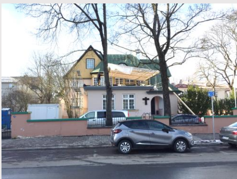
Obras en el tejado del seminario
